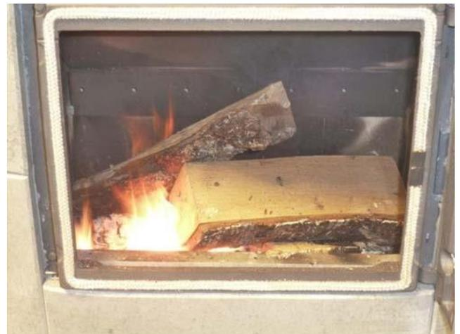
11. Sollte die Ofentemperatur nach einiger Zeit zu hoch sein, können Sie das Luftventil weiter schließen, um das Holz im Ofen langsamer brennen zu lassen.
