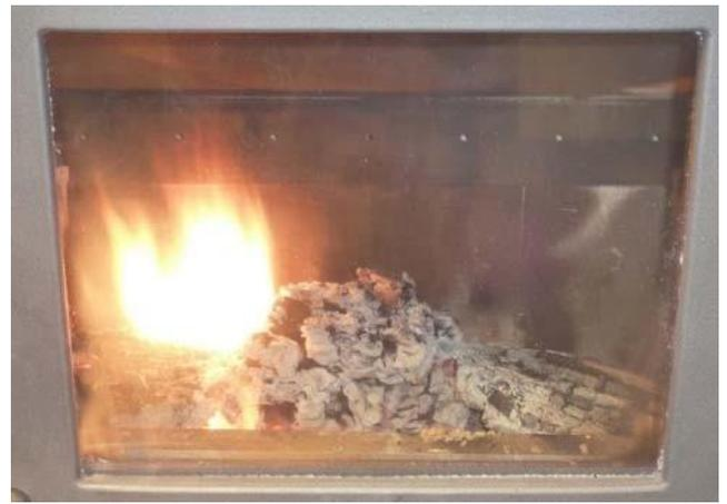
10. Legen Sie 2 bis 3 faustgroße Holzblöcke nach. Verteilen Sie diese so gut wie möglich in der gesamten Verbrennungskammer. Legen Sie die Blöcke nicht zu nahe an die Ofentür. Platzieren Sie die Blöcke mit der Rinde nach unten. Achtung: Aufgrund der hohen Temperatur in der Verbrennungskammer kann es sein, dass das Holz direkt Feuer fängt. Schließen Sie die Ofentür. Erst nachdem sich die Blöcke entflammt haben, können Sie die Luftzufuhr gegebenenfalls reduzieren.
