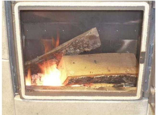
11. Si, après un certain temps, la température dans la pièce devient excessive, vous pouvez encore réduire l'arrivée d'air à l'aide du clapet d'admission, pour que le poêle brûle plus doucement. Vous pouvez également obtenir une combustion plus lente en utilisant des bûches plus grandes ou en unissant les bûches de petites dimensions.
