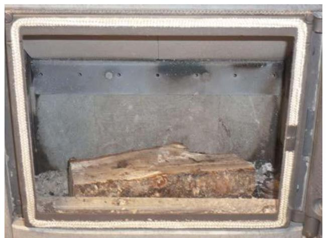
4. Placez encore 3 à 6 bûches plus petites par dessus, jusqu'à atteindre le tuyau d'arrivée d'eau le plus haut. Placez les bûches le moins possible les unes contre les autres, de manière à ce que l'air puisse bien circuler lors de la combustion. Ne placez pas les bûches trop près du mur arrière, de manière que suffisamment d'air puisse arriver par l'arrière dans l'espace de combustion.
